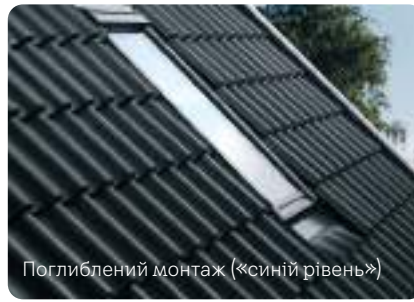
Примітка: Між віконною рамою і кроквами для каркаса утеплювача потрібно 4 см відстані з обох сторін
