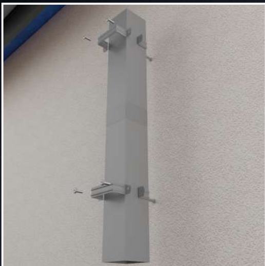
Водостічні труби монтуємо із застосуванням обійм, а між собою з'єднуємо за допомогою муфт.
