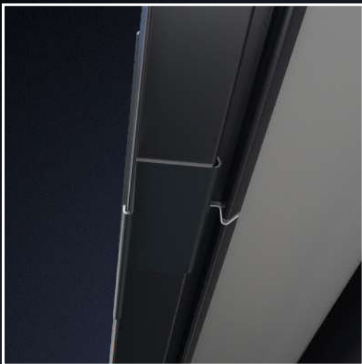
З'єднувач накладено на накладку ринви.
