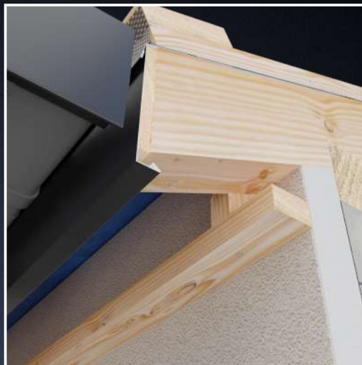
Облаштовуємо підконструкцію для монтажу підшиви.
