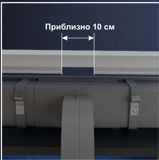
Виріз для зливу лійки повинен бути шириною приблизно 10 см.
