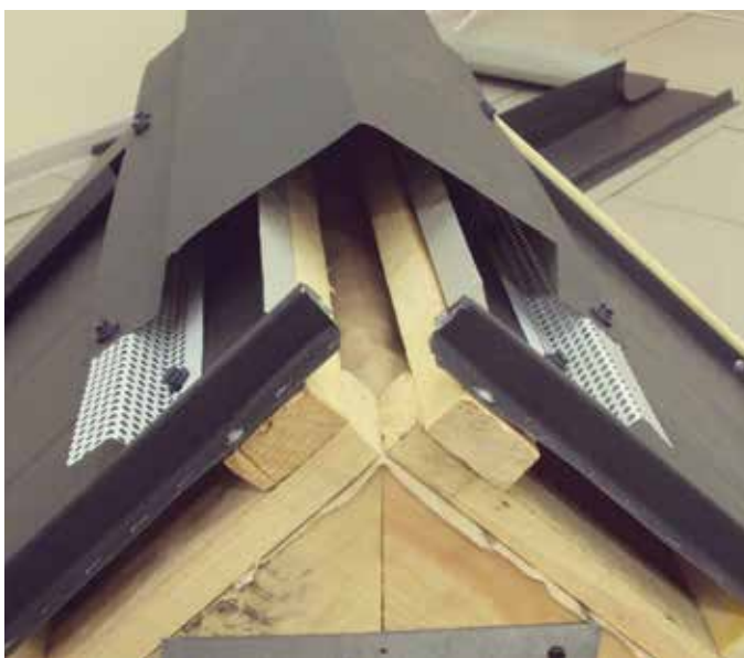
Рис. 34. Монтаж трапецієвидного конька
