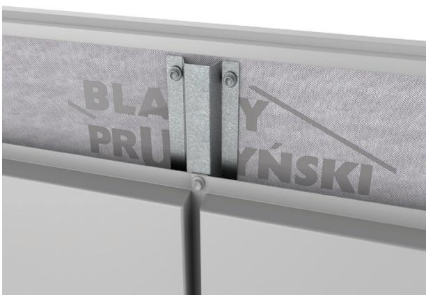
Рис. 10.1. Вертикальне з'єднання касетонів з відкритим стиком
