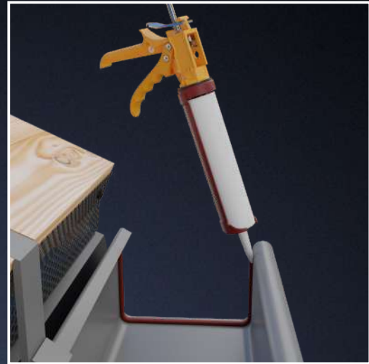
Перед монтажем заглушки наносимо ущільнювальний клей на край ринви.
