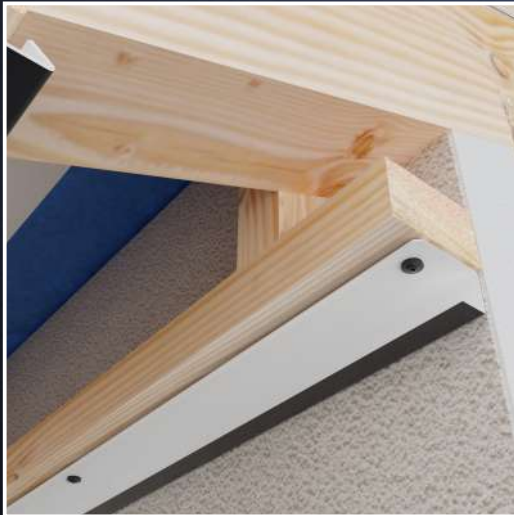
Монтуємо профіль J до дерев'яного бруска.
