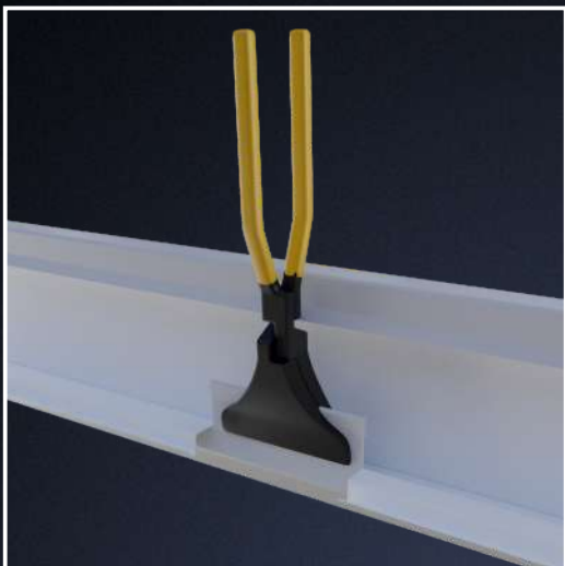
Підгинаємо вирізану частину накладки ринви.
