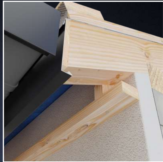
Облаштовуємо підконструкцію для монтажу підшиви.
