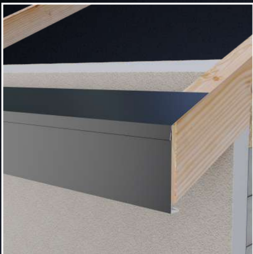
Монтаж верхнього звісу (крапельника).
