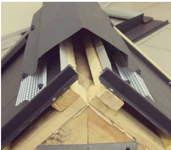
Рис. 34. Монтаж трапецієвидного конька
