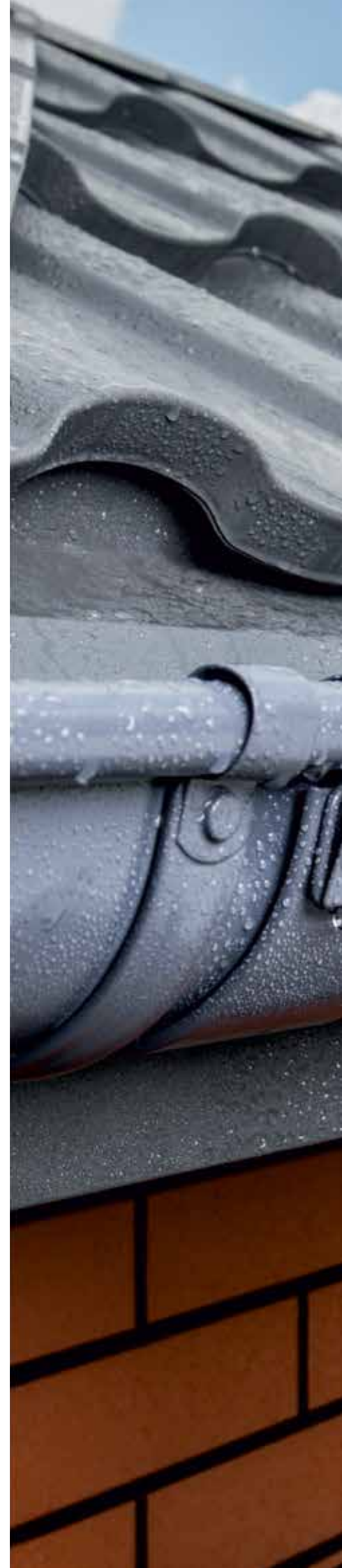
Встановлення заглушки після монтажу ринви на гаках
