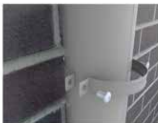
Скручування обійми за допомогою болтів
