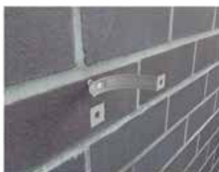
Монтаж обійми до стіни за допомогою шурупа з розпірним дюбелем
